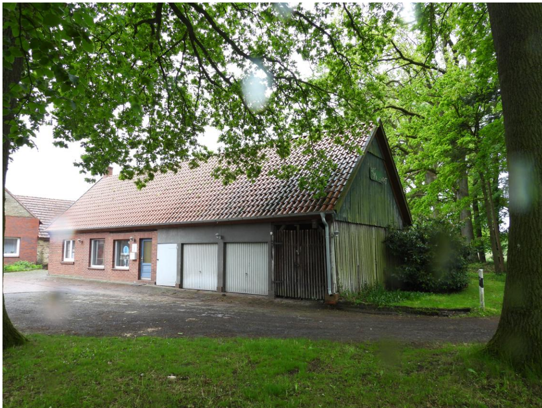
Abbildung 3: Gebäude an der Bramscher Allee 100 mit zahlreichen Potenzialen und tatsächlich gefundenen Quartieren
