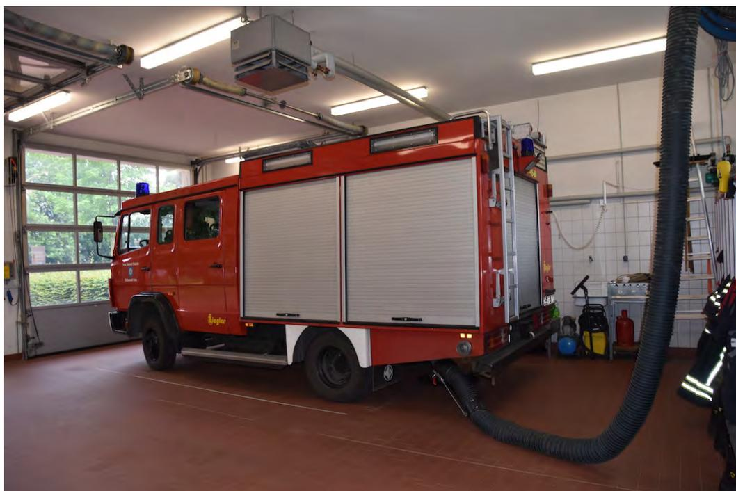
Abb. 7.3-50: OF Pentz: Fahrzeughalle mit LF 8/6 und Abgasabsauganlage (Flüssiggasflasche)
