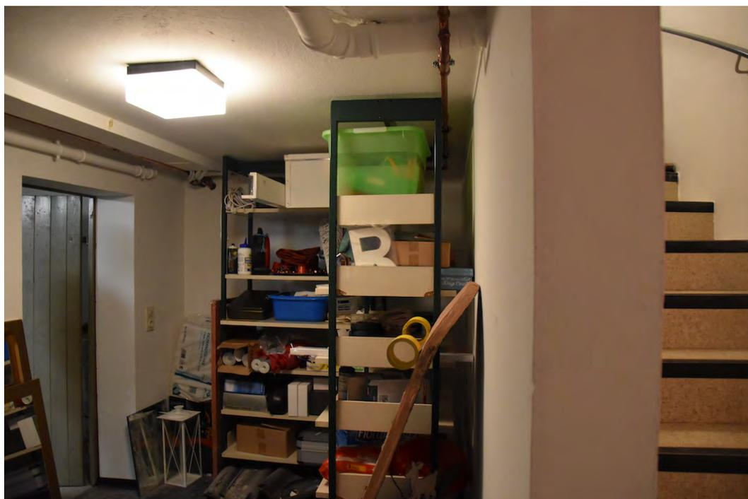
Abb. 7.3-10: OF Achmer: Unsachgemäße Lagerung von brennbaren Materialien im Treppenraum
